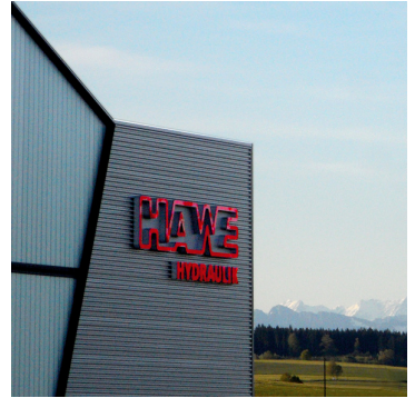
Vue sur les Alpes depuis l'usine HAWE de Kaufbeuren
